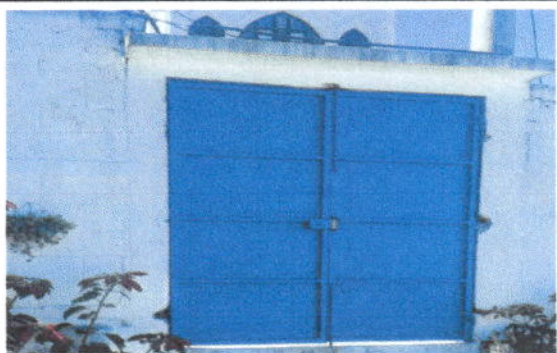
Foto 3: Sustrucción de portn en entrada principal.
