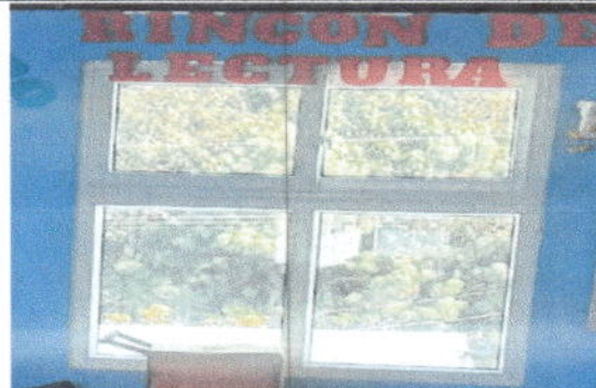
Foto 4: Sustrucción de estructuras de metal de ventana a pvc en aula.
