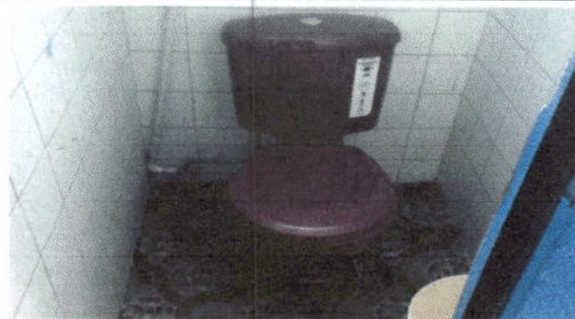
Foto 8: Sustitución de inodoros y sus accesorios
