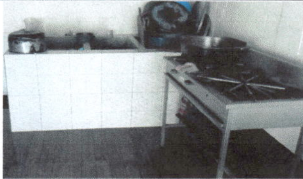
Foto13: Sustrucción de pila de dos lavaderos en cocina.
