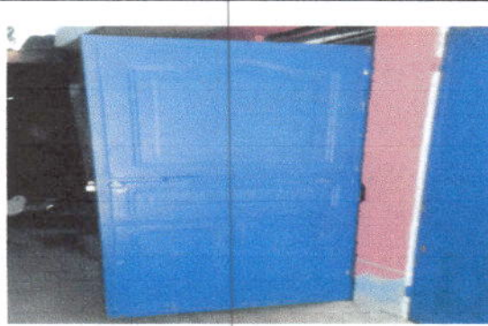
Foto 2: Sustrucción de puerta en servicio sanitario.
